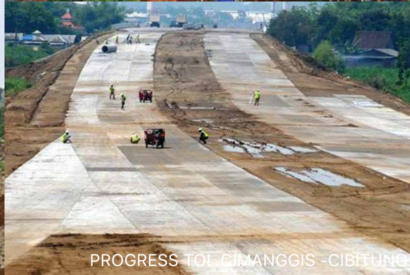
PROGRESS TOL CIMANGGIS -CIBITUNG
