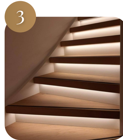
Smart Light Sensor ระบบไฟส่องสว่างอัจฉริยะ
